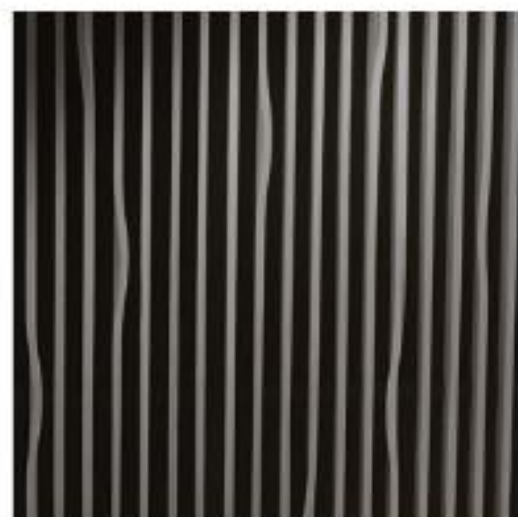
V3: Befintlig absorberent demonteras, lackas och återmonteras. Kulör grå, NCS S-5502-Y.
